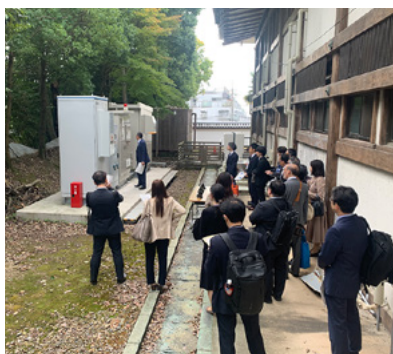
蓄電池システムの見学
