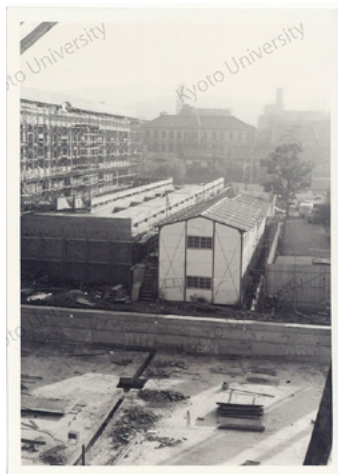
施工写真(京都大学総合体育館) 資料情報: [京都大学総合体育館](部分), Ar MIXED 2017/2/S5-02/164, “増田友也建築設計関係資料, 1930-1984 (主年代1950-1981).”
