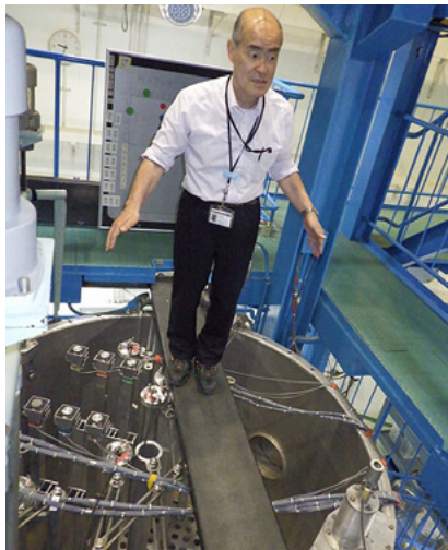
原子炉の上に立って説明する三澤副所長 原子炉と制御棒（中心の6本の棒が制御棒）
