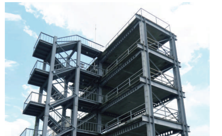
宇治キャンパス(防災研究所 鋼構造実大試験架構)
