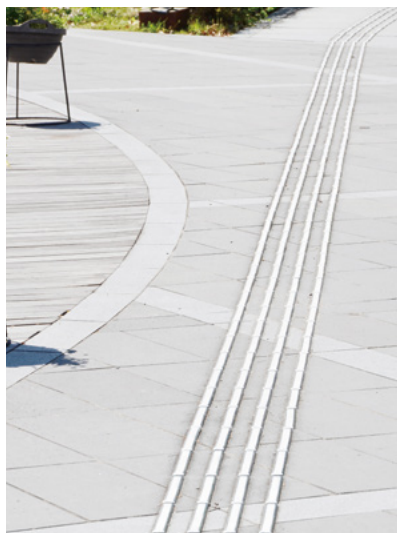
構内に設置された点字ブロック
