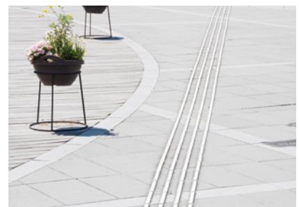
構内に設置された点字ブロック
