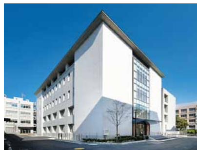
物質-細胞統合システム拠点研究棟
